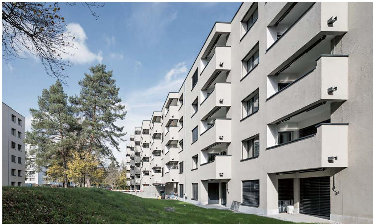
Ansicht des Innenhofs und der rückseitigen Fassaden der **Wohnsiedlung Paradies** nach der Erneuerung. Die Originalstruktur mit den abgestuften Balkonen blieb trotz zusätzlicher Aussendämmung gewahrt.
