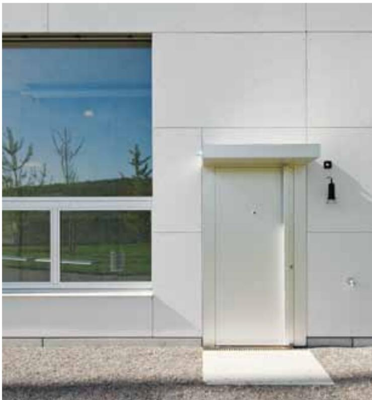
Hinterlüftete Leichtbaufassaden mit Eternitplatten definieren einen präzise geschnittenen Baukörper und unterstützen die Identität des eigenwilligen Gebäudes.
