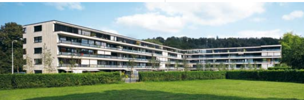
So präsentiert sich der gesamte Baukörper auf der Hofseite vom Nachbargrundstück gesehen.
