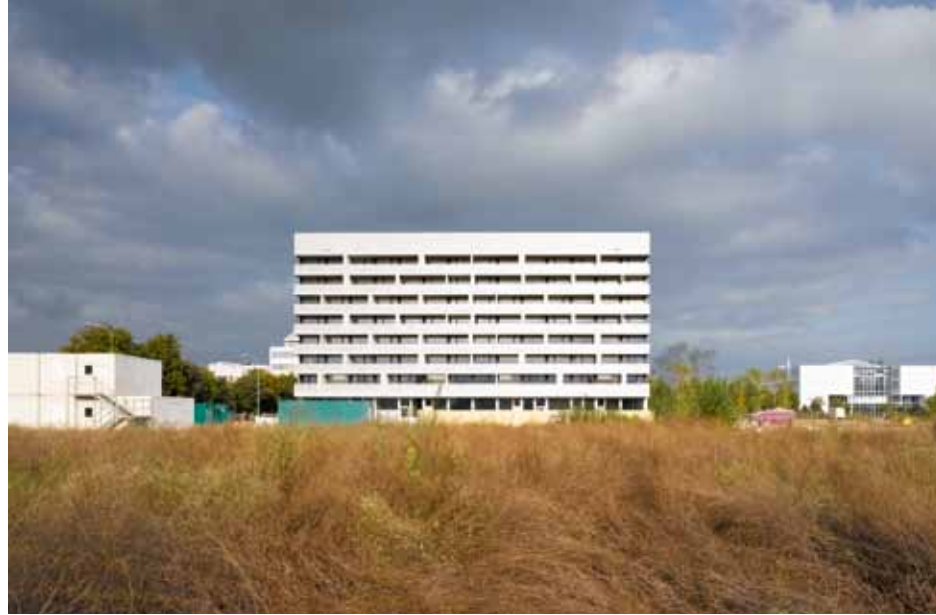
Wohn- und Geschäftshaus Baufeld A4, Färbi-Areal, Schlieren; Investor: Immobiliengesellschaft IMMOSIP AG, Zürich und Halter AG Generalunternehmung, Zürich; Architektur: Galli Rudolf Architekten, Zürich; Städtebauliches Gesamtkonzept 2003, Gestaltungsplan 2005, Planung/Ausführung 2006–2009 (S.15 Gebäude rechts: novaron Architektur) Bilder: Hannes Henz
