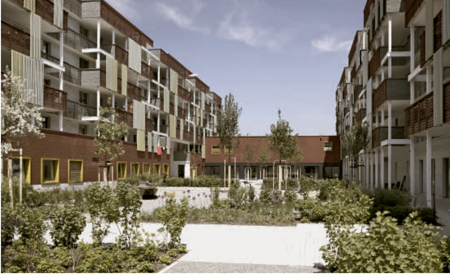
Holzbau mit System: In der Giesserei wird das gemeinschaftliche Zusammenleben auch mit architektonischen Mitteln gefördert FOTO: HANNES HENZ
